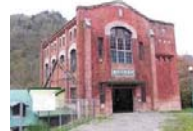
(写真: 滝の上発電所 2,340kW)
