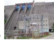
(写真: ニ設発電所 14,700kW)
